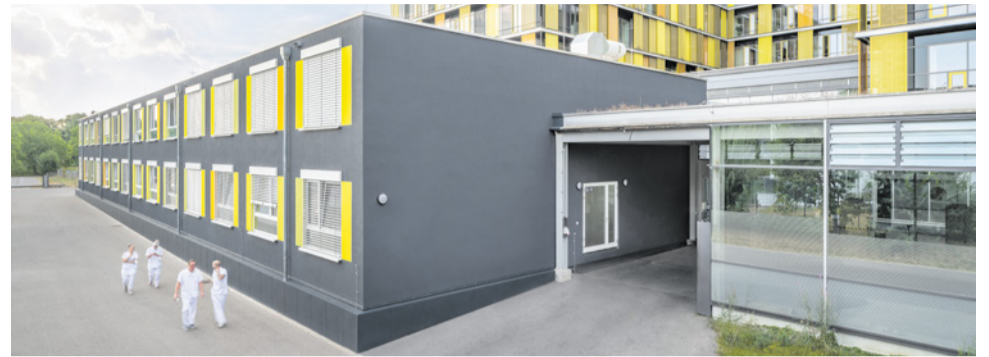
Die Isolierstation am Klinikum Winnenden wurde mit Unterstützung des Rems-Murr-Kreises 2021 während der Pandemie neu errichtet. Foto: Cadolto Modulbau GmbH
