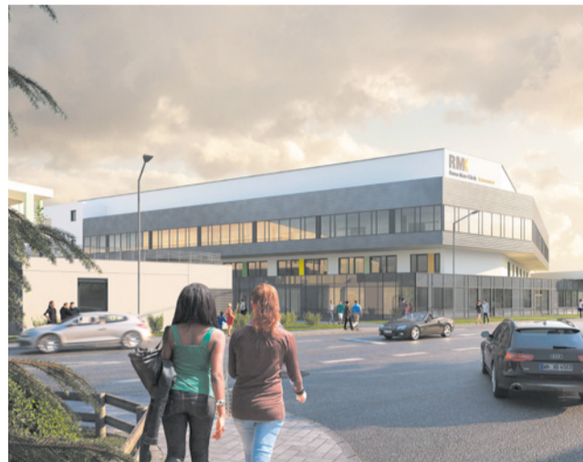
Der geplante Funktionsbau der Rems-Murr-Klinik Schorndorf, hier von der Straße aus betrachtet, wird Herzstück der Klinik.
