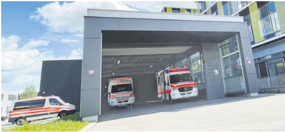
Kurze Wege: Die Rettungswagenhalle des Rems-Murr-Klinikums hat direkten Zugang zur Interdisziplinären Notaufnahme.
